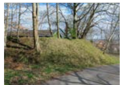
Förrådsbyggnaden ligger skyddad av en vall.
