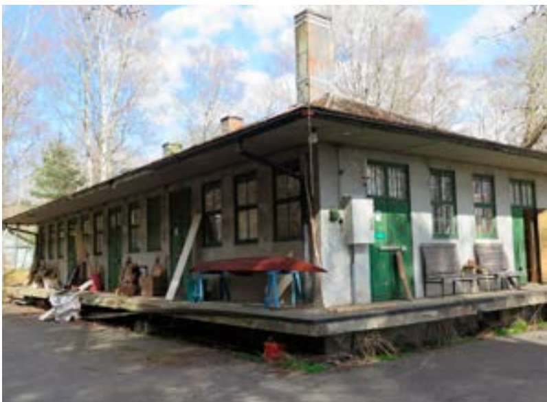
Här syns den västra och den södra fasaden. Notera lastbryggorna, de tätt placerade fönstren liksom de generöst tilltagna portarna.
