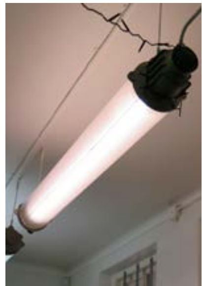
Lysrören i taket är troligen från byggnadstiden med specialinkapslade rör och flera extra säkerhetsanordningar.
