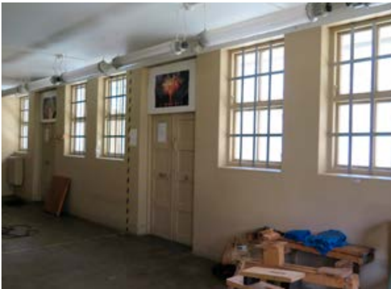
Interiören är robust och de många fönstren ger ett bra arbetsljus för verkstadsarbetet.
