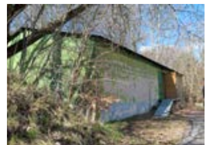
Förrådsbyggnad öster om verkstaden.
